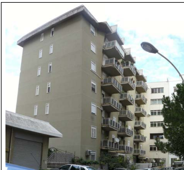
Vista prospetto principale
