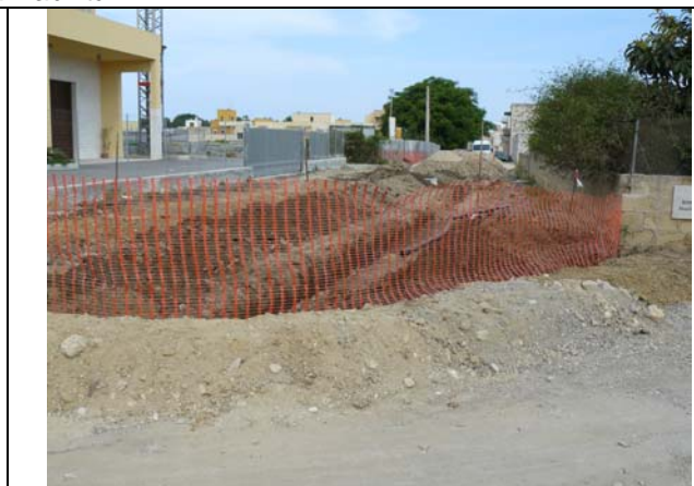
Opere di Urbanizzazione
