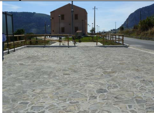
Esterno Stazione Lago
