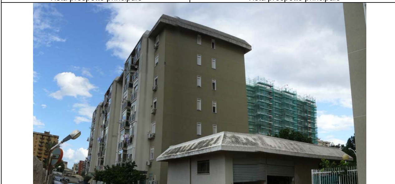
Vista prospetto sul retro
