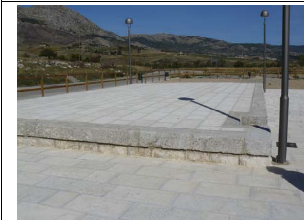
Esterno Stazione Lago
